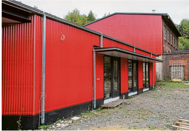
Blick auf die Baustelle: Schon der Rohbau und die feuerwehrote Fassade verraten, dass das Arfelder Dorfgemeinschaftshaus gewohnte Bahnen verlässt.
