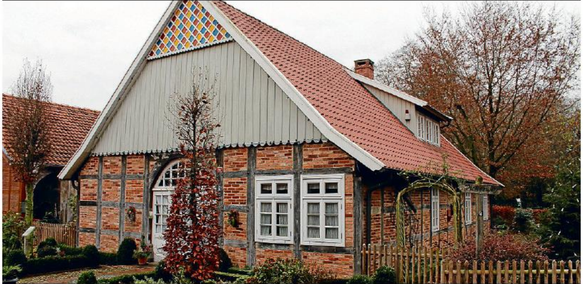
Ein sehr gutes Beispiel: Viele Vördener sind stolz auf das restaurierte und längst wieder viel genutzte Ackerbürgerhaus im Herzen des Ortes. Sie wünschen sich den Erhalt von wesentlich mehr alten Gebäuden, nicht nur im Ort. Foto: Heinzler
